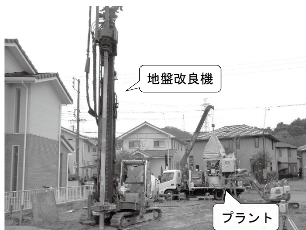
(i) 固化材・水を混合するプラントと地盤改良機
