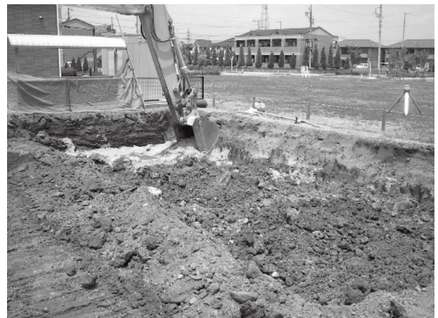
(ii) 固化材と土の混合
