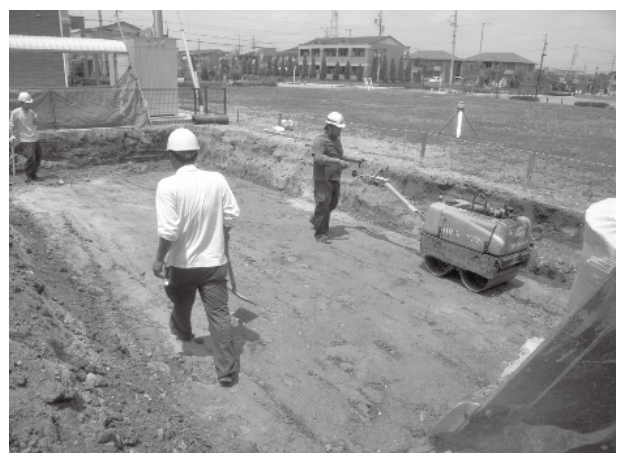
(iii) 小型ローラーによる転圧
