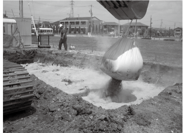
(i) 固化剤投入
